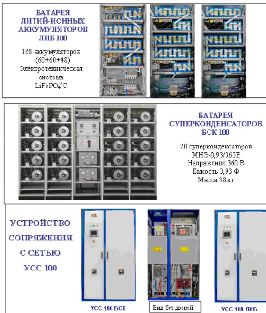
Рис.2. Общий вид ГНЭ-100 и его подсистем.
